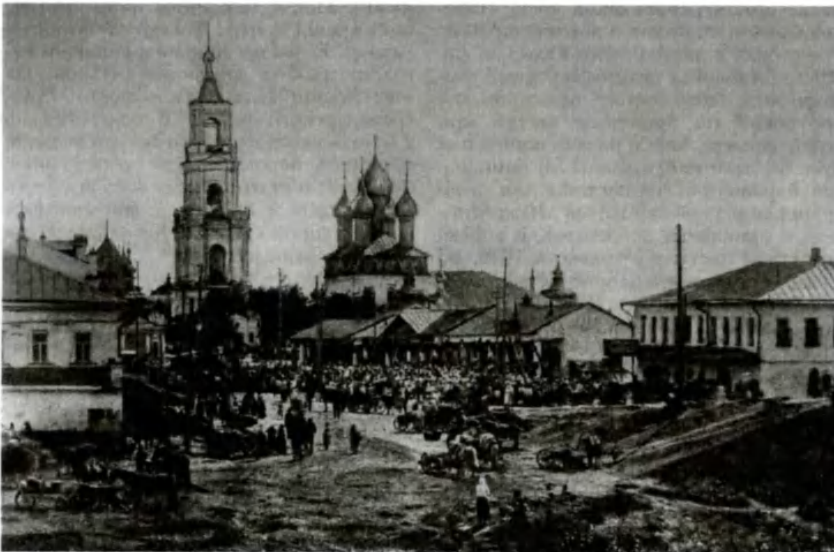
г. Нерехта. Центральная площадь.
