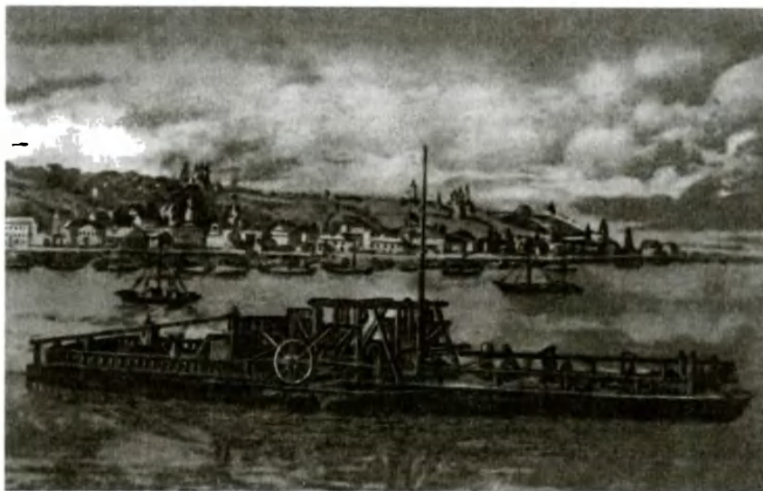
Водоходное машинное судно, построенное по проекту И. П. Кулибина, при испытаниях на Волге у Нижнего Новгорода.
